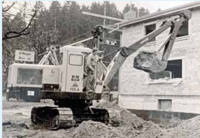
Aushub mit dem ersten Bagger im Jahre 1956.
